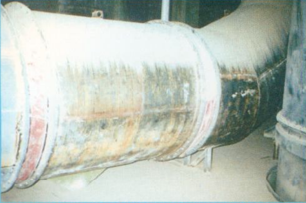
VAUTID-100 aşınma plakalarından imal edilmiş çimento sevk borusu ve dirseği
