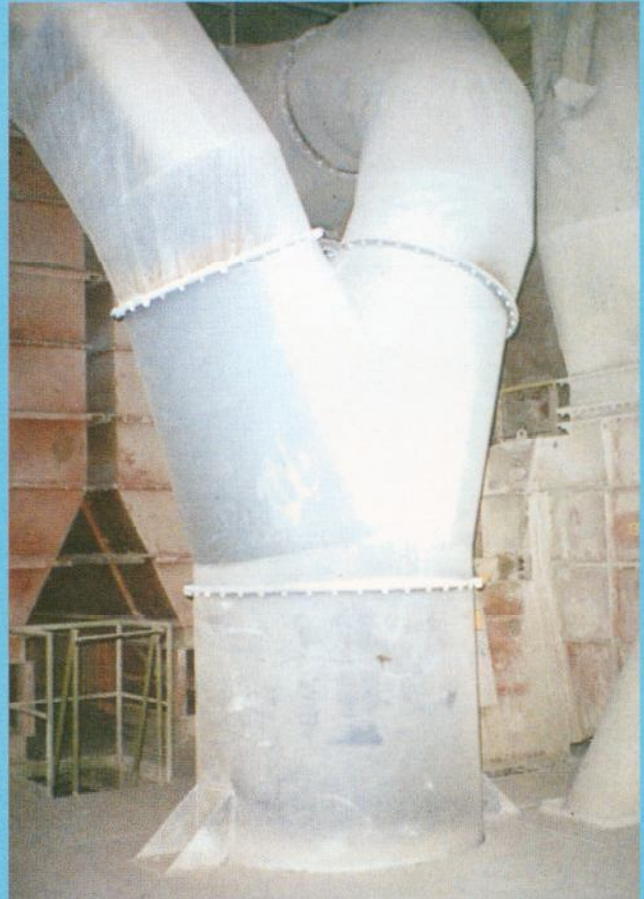
Yüksek kapasiteli bir seperatörde çimento şevki için kullanılan, komple VAUTID-100 aşınma plakasından İmal edilmiş bir pantolon boru
